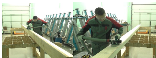
Рис. 1. Процесс строгания граней деревянных заготовок
