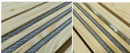
Рис. 4. Процесс вклейки армирующих элементов в балку
