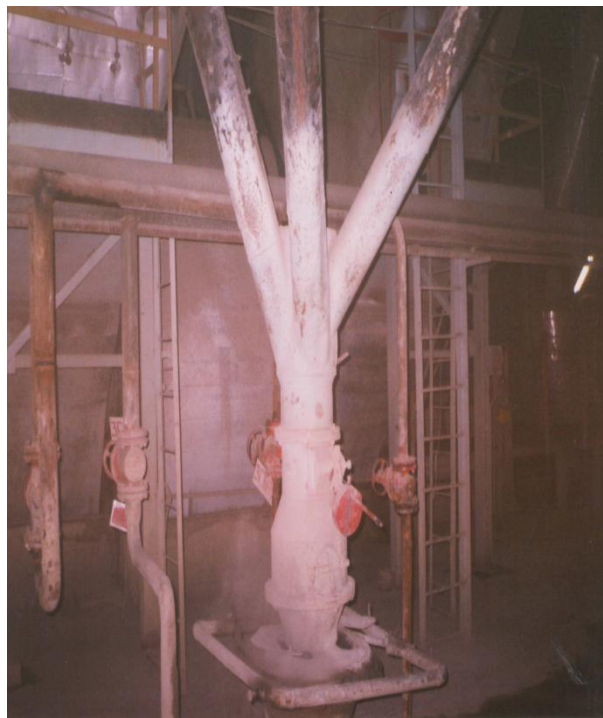
Рис. 2. Присоединение трех течек от бункеров электрофильтра к устройству для централизованного сброса золы
