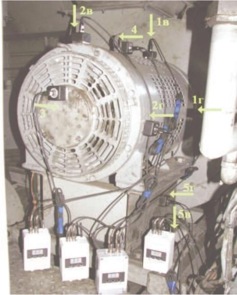
Рис. 8. Измерение вибрации на МВ-4.
