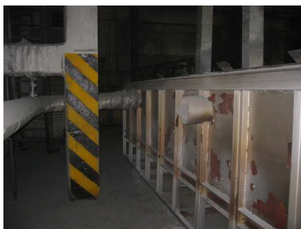
Рис. 2. Задняя стенка контейнера охлаждения анодных огарков с газоотводящим патрубком.
