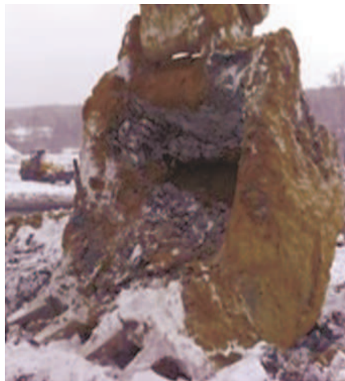
Рис. 1. Ковш экскаватора с намерзшим грунтом.
