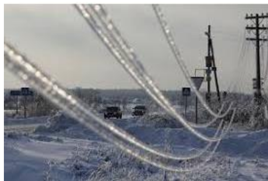
Рис. 3. Различия стрел провеса проводов при гололёде
