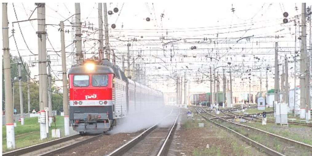
Рис. 1. Контактная сеть трехпутного участка
