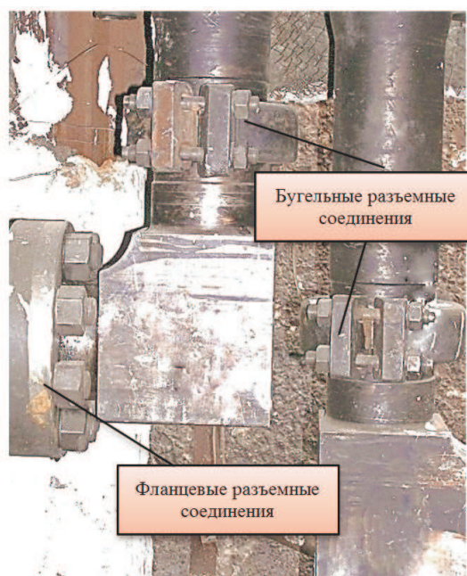
Рис. 2. Бугельное разъемное соединение на параметры Ду120 Ру32 МПа, смонтированное на химическом заводе АО «АНХК»
