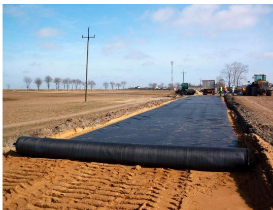
Рис.1. Применение геотекстиля в дорожном строительстве
