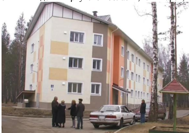
Рис. 2. Энергоэффективный дом в Иркутской области, г. Ангарск, квартал 251, дом 17
