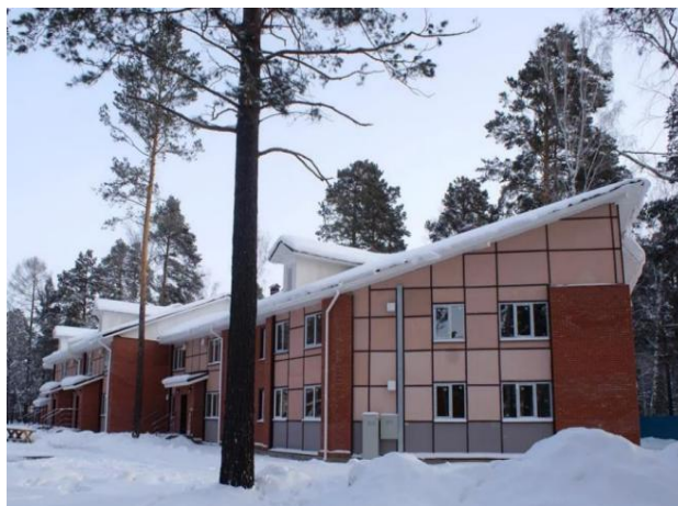
Рис. 1. Энергоэффективный дом в Иркутской области, г. Ангарск, квартал 251, дом 14
