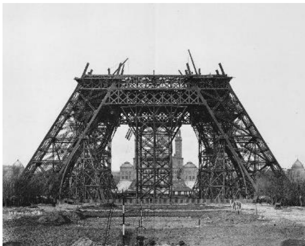
Рис. 3. Возведение первого яруса башни
